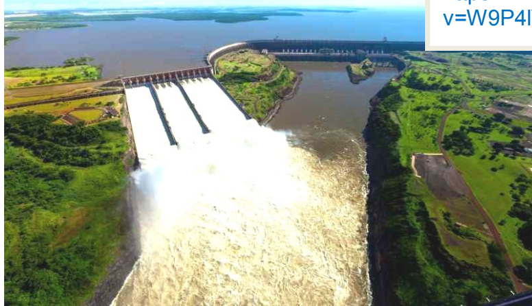
HIDRELÉTRICA DE ITAIPU
